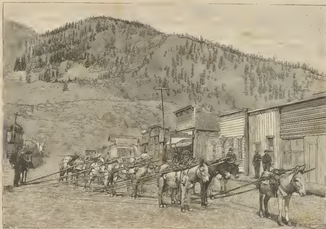
Fig. 3. Silverton. Partida de una expedición para la construcción de una vía férrea. Transporte de rails á lomo de asnos
